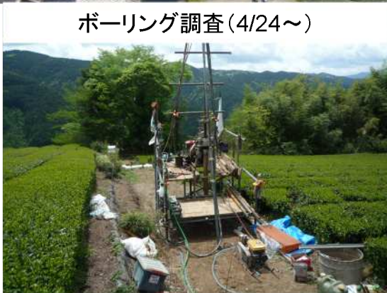
ボーリング調査中
