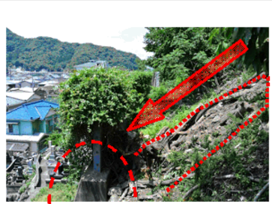
① 5月17日(火)に西伊豆町の「安良里向田」のコンクリート擁壁が崩壊土砂をストップ!
