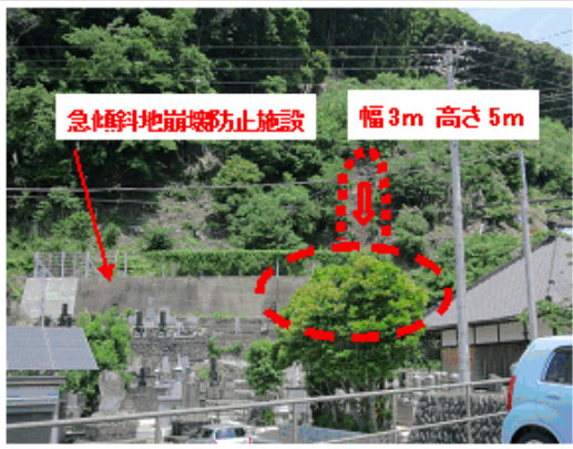
① 5月17日(火)に西伊豆町の「安良里向田」のコンクリート擁壁が崩壊土砂をストップ!
