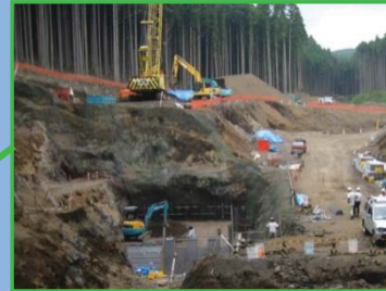
風祭第1砂防えんていの工事状況
