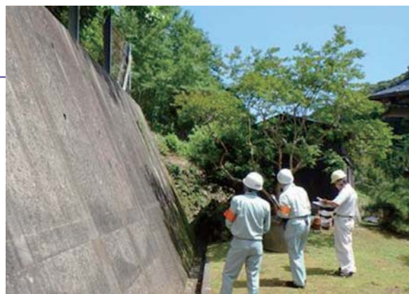
急傾斜地パトロールの状況
