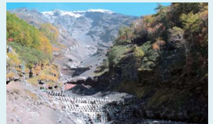
崩壊地と対策工
