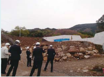
仏沢川砂防事業の現場見学
