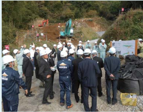
「長尾地区(砂防)」工事現場にて
