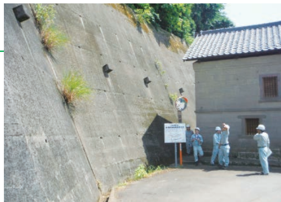
急傾斜地パトロールの写真
