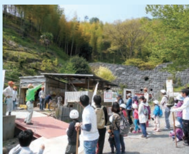
砂防堰堤前の全体説明
