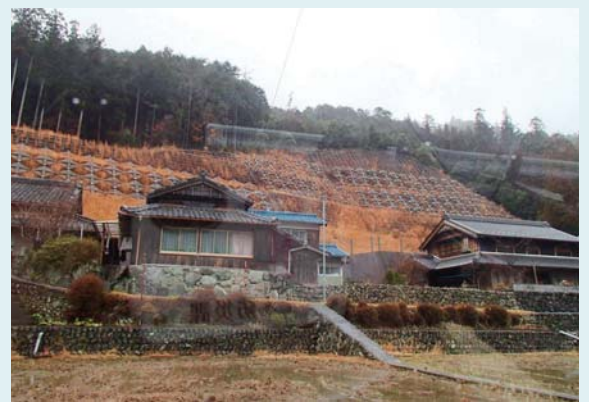
領内地区(地すべり対策)の状況
