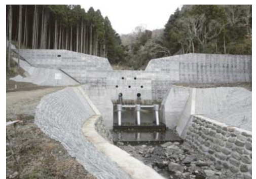
濁川砂防堰堤
