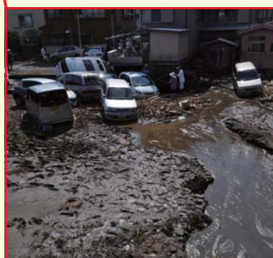
安良里浜川土石流被害状況
