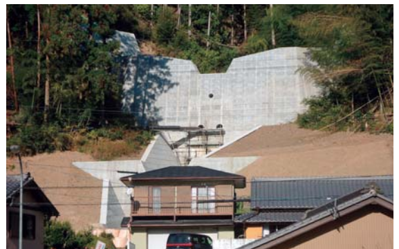
下田沢砂防堰堤(施工中)
