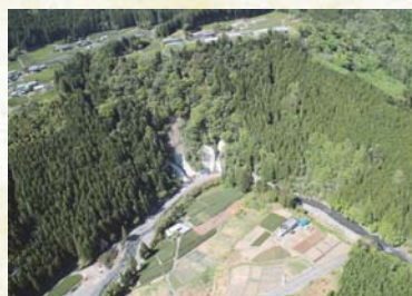
写真-1 崩壊発生前 (H25.4.22 撮影)
