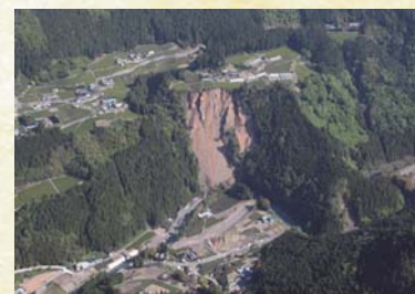
写真-2 崩壊発生後 (H25.4.27 撮影)
