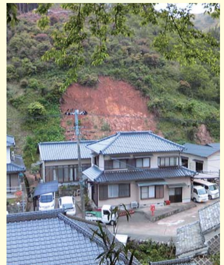
人家裏のがけ崩れ (南伊豆町青市)
