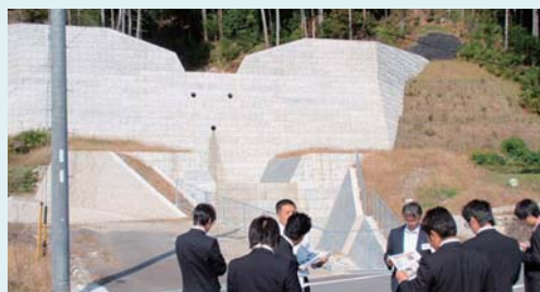
災害関連緊急砂防事業にて完成した堰堤（岐阜県八百津町）
