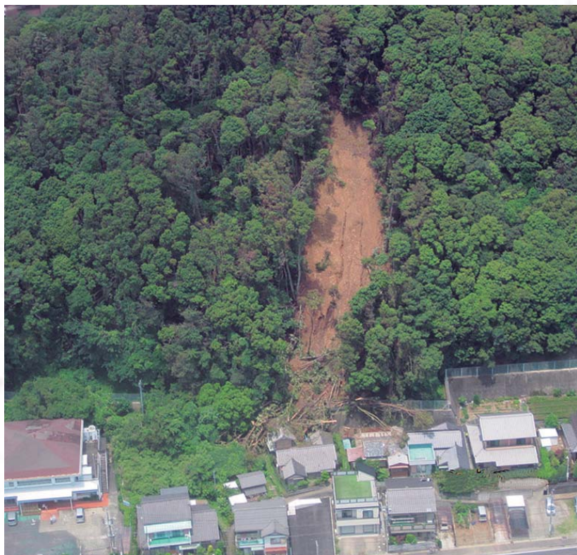
牧之原市静波で発生したがけ崩れ
