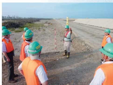
関上・北釜地区現場視察説明の様子
