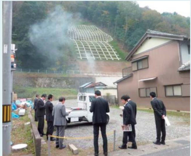
盛住地区急傾斜現場
