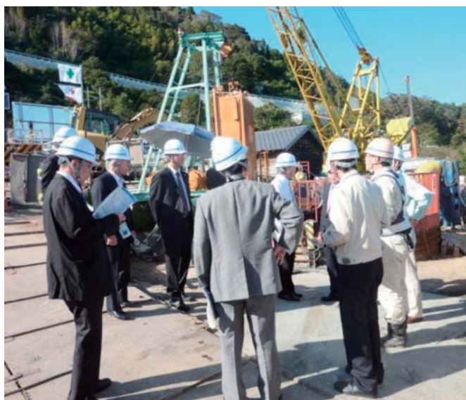
工事現場視察の様子
