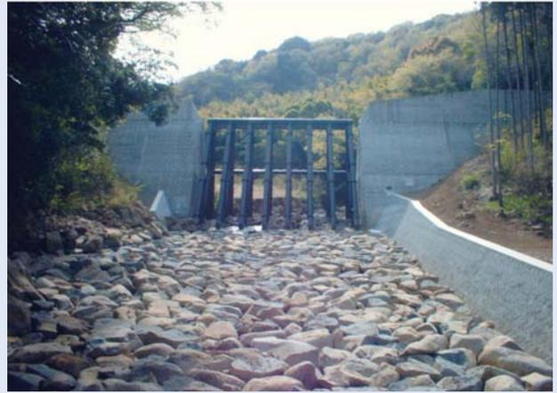
立保川では、既設の不透過型砂防堰堤の上流に、透過型の砂防堰堤1基の整備を行い、下流域の人家26戸、西浦郵便局、県道沼津土肥線、市道の保全を図りました。
