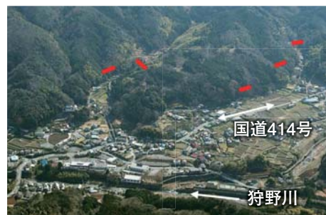
災害時要援護者施設や国道414号を保全する市山地区砂防堰堤群（事業中）
