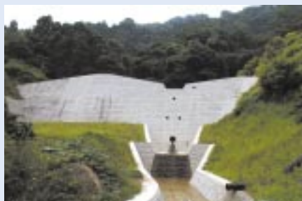
蓮性寺沢砂防えん堤 (静岡市清水区谷津地先)
