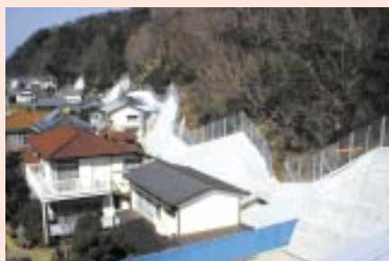
小山家 (賀茂郡西伊豆町仁科地内)
