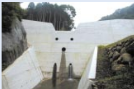
浦上川砂防えん堤 (賀茂郡西伊豆町安里地先)
