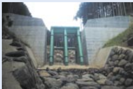
金敷川砂防えん堤 (田方郡函南町丹那地先)
