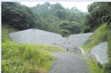
柳沢砂防えん堤 (志太郡岡部町内谷地先)
