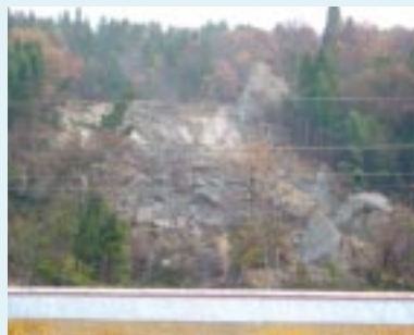
小千谷市被災状況
