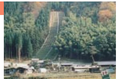
東内戸急傾斜地全景
