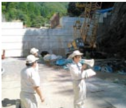
真野川通常砂防工事現場
