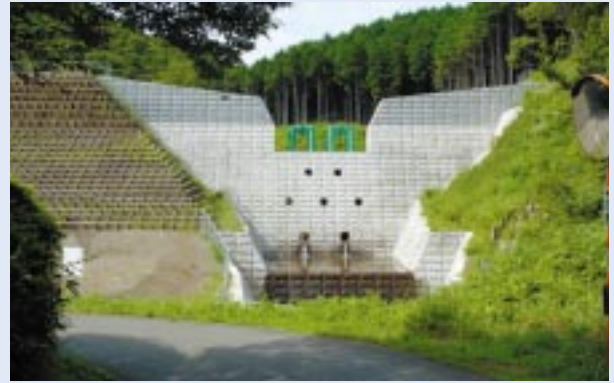
ふかさわがわ 深沢川砂防堰堤
