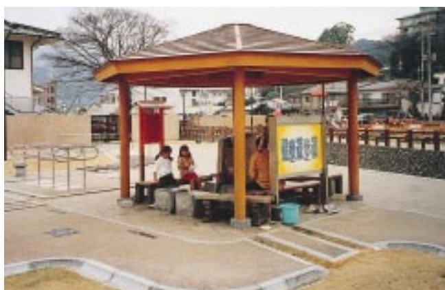
湯らっくす公園の足場
