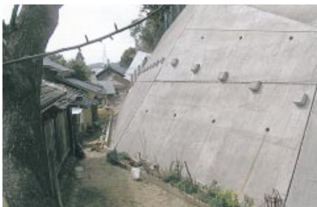
勝佐急傾斜崩壊危険区域
