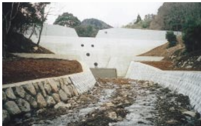
熊明ノ沢砂防堰堤
