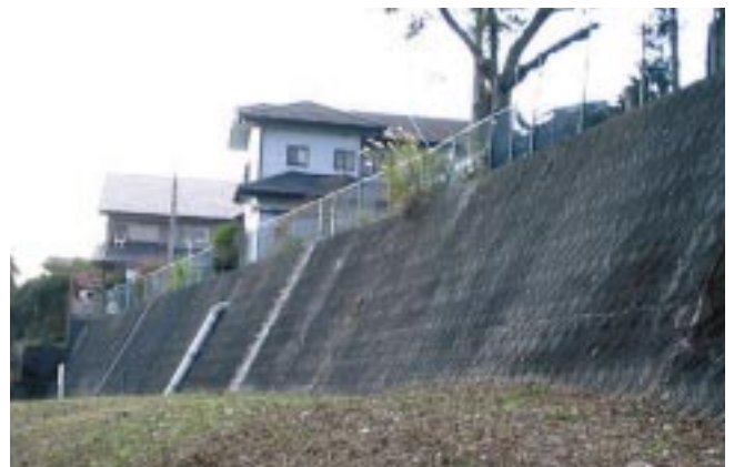
於呂急傾斜地崩壊危険区域
