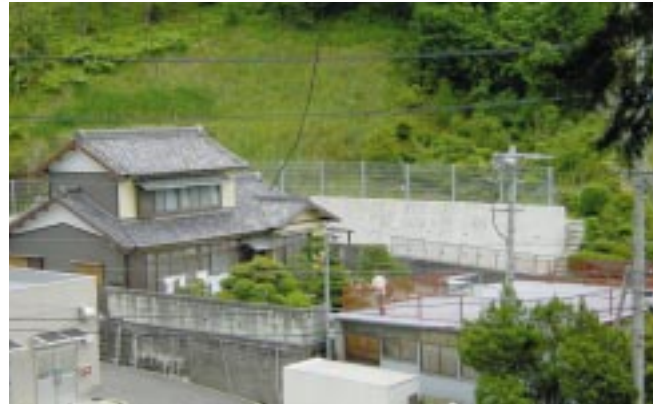
西之谷急傾斜地崩壊危険区域
