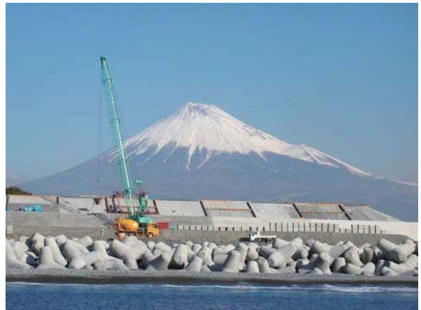
廃棄物埋立護岸築造の様子(平成12年頃)
