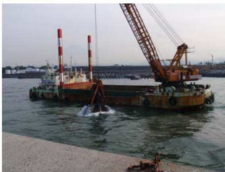
グラブ船による浚渫
