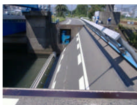
沼川水門橋 長さ20メートル×2基
