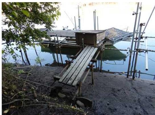
栈橋(鋼管パイプ、渡し板)
