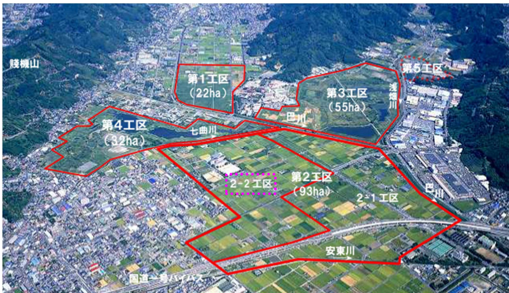
图 5.6 麻機遊水地 2-2 工区整備箇所
