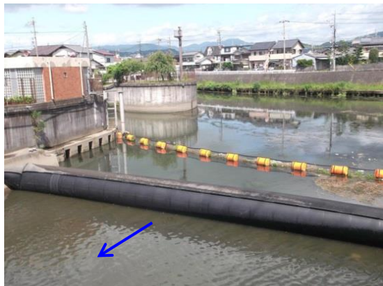
<大谷川放水路 分流堰>
