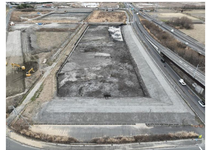
R4 豊地エリア 築堤工（継続中）
