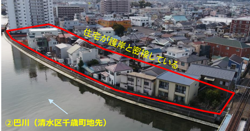
対策予定箇所の状況
