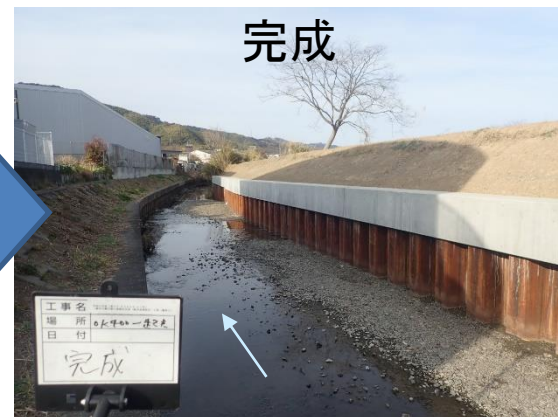
笠コンクリート工の施工
