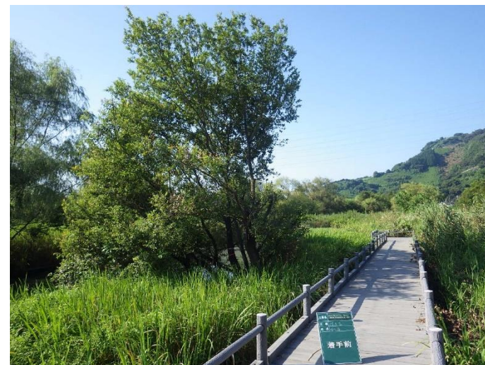
麻機遊水地4工区 伐木工 着手前（遊水地内）
