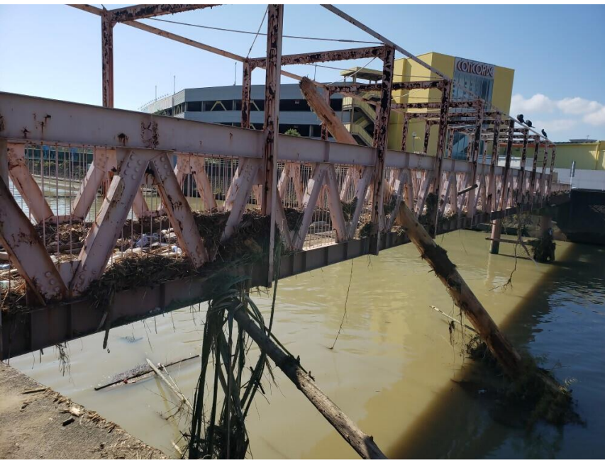
台風第15号で流木等が引っ掛かった橋梁を撤去することで、巴川本川の流下断面を確保する
