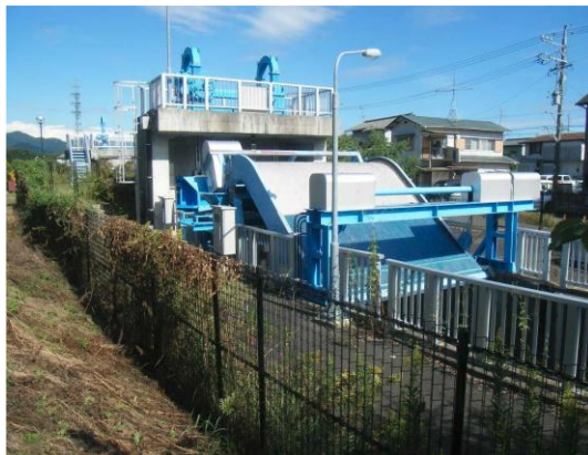
<七曲川逆流防止樋門>
