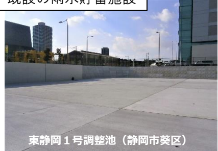
既設の雨水貯留施設
