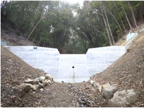
治山施設(谷止工)の設置
