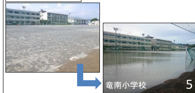
雨水貯留浸透施設
