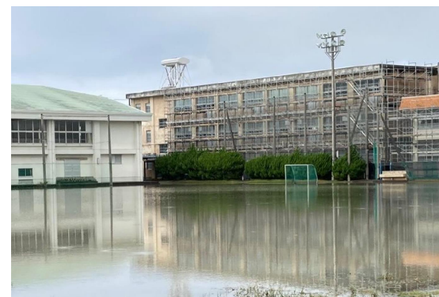
校庭雨水貯留施設 (清水小学校)
