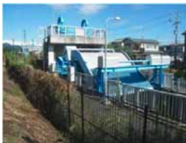
<七曲川逆流防止樋門>
