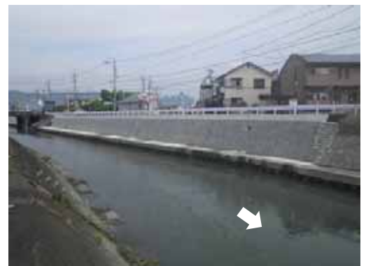
(二) 巴川 静岡市葵区上土（完了箇所）
