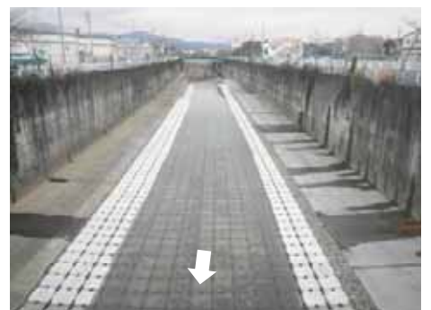
H27護床ブロック据付状況（中土呂橋上流）
