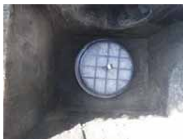
浸透管設置後
