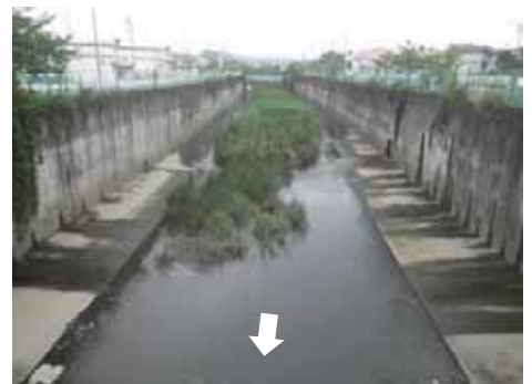
H27護床ブロック据付状況（中土呂橋上流）
