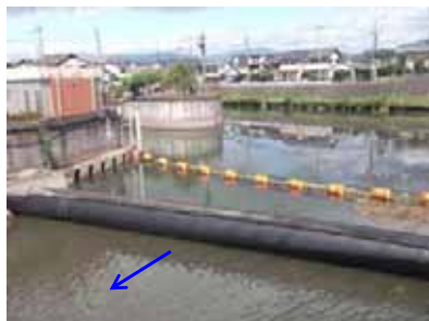
<大谷川放水路 分流堰>
