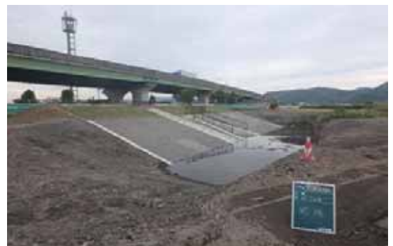
R2 立石エリア 流入樋門工
