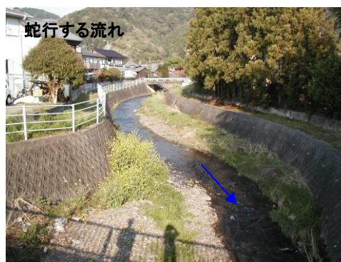
図 2-38 上流部の河道の状況 - 葵区北 -
