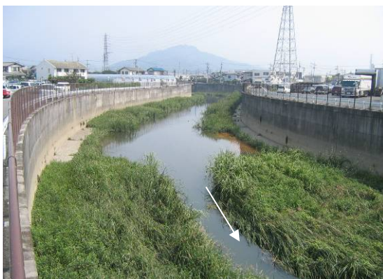
大谷川放水路 -葵区古庄 2 丁目
