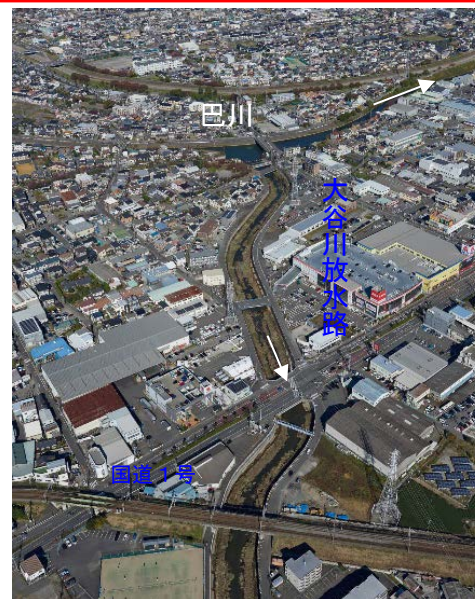
大谷川放水路分流堰 -葵区古庄-
