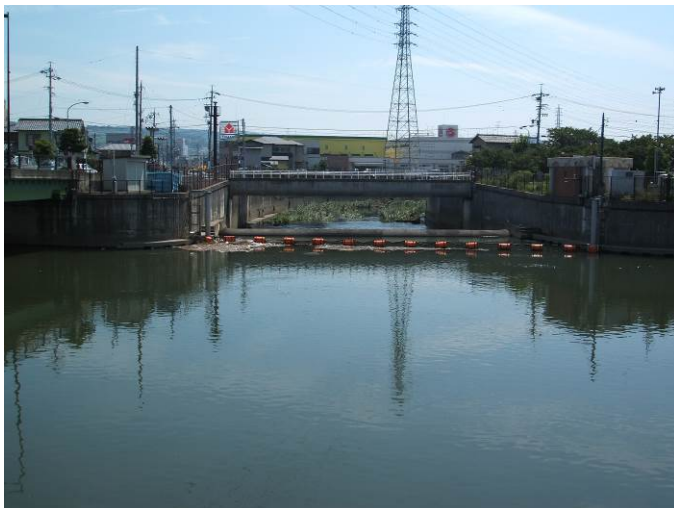
大谷川放水路分流工 -葵区古庄-
