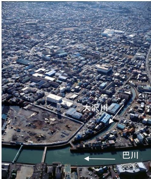
図 1-57 大沢川下流部 -清水区東大曲町付近-
