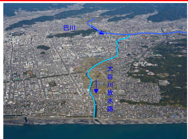
図 1-8 大谷川放水路全景
