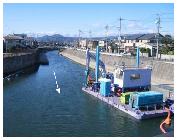
図 2-32 河川浄化の状況 (底泥の浚渫)
