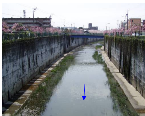
図 2-46 大谷川放水路の状況 - 駿河区小鹿 -
