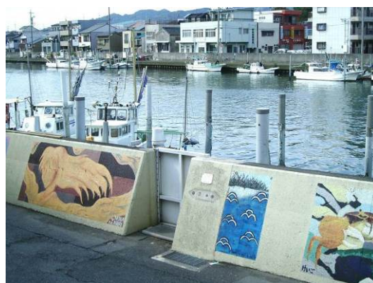
パラペット堤 -津波対策-
