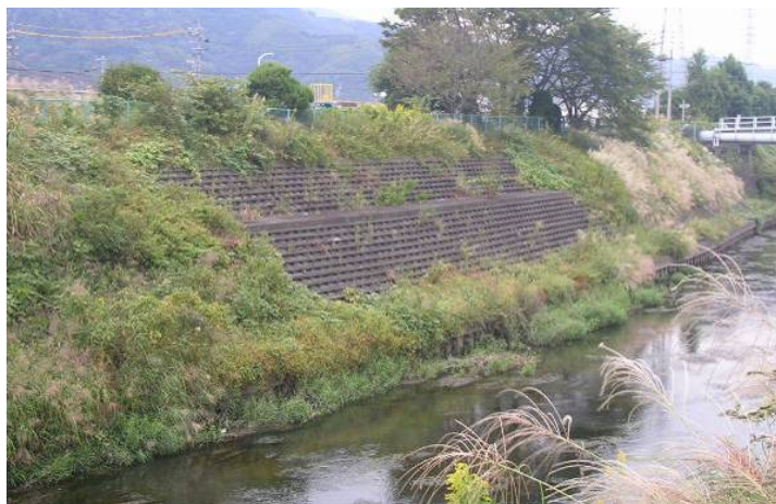
図 2-29 階段護岸の状況 -巴橋上流-
