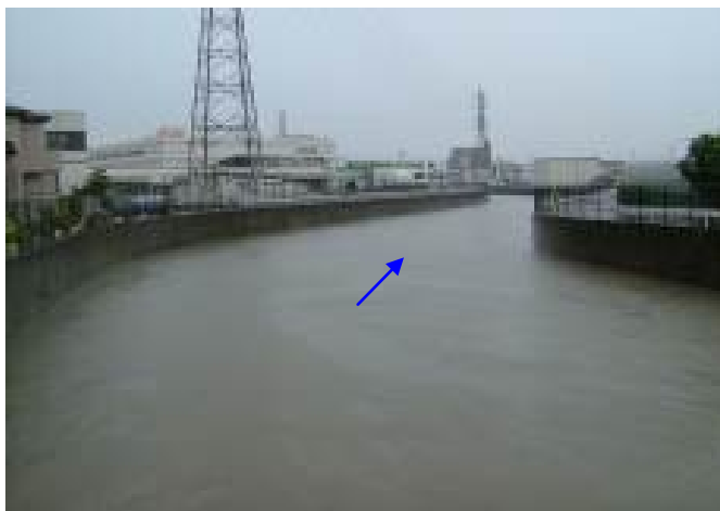
大谷川放水路 -葵区古庄-
