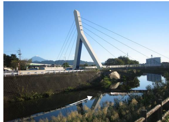
図 2-23 高部みずべ公園 -巴流大橋-
