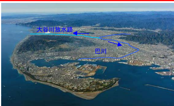
図 1-7 巴川下流部全景
