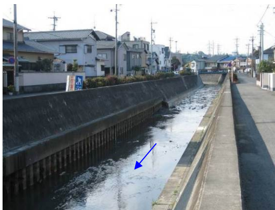
大沢川下流部の改修状況 -新追分橋付近-
