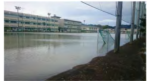
雨水貯留浸透施設の様相 (市立竜南小学校 平成26年10月撮影)
