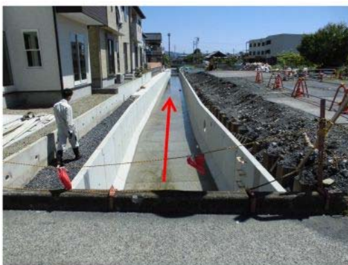
写真 2-5 雨水きよ整備
