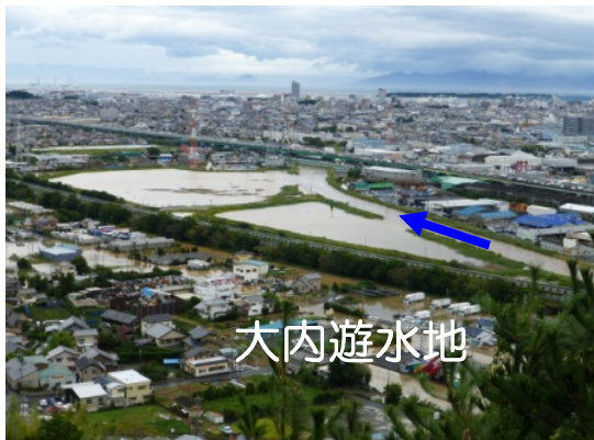
写真 2-2 大内遊水地(平成 20 年完成)
