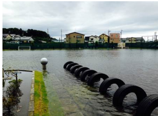
写真 2-6 雨水貯留浸透施設
