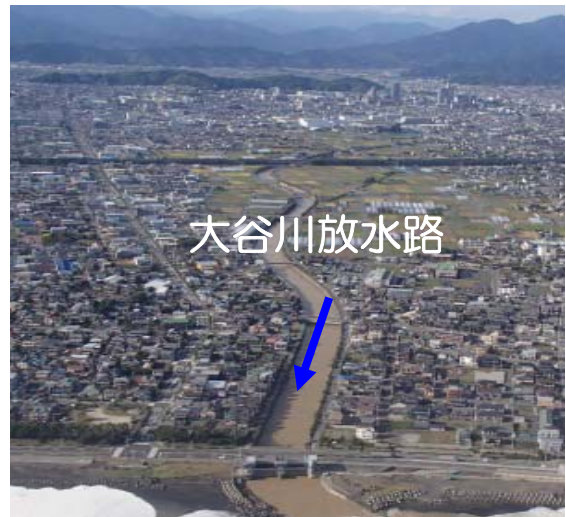
写真 2-3 大谷川放水路(平成 11 年完成)
