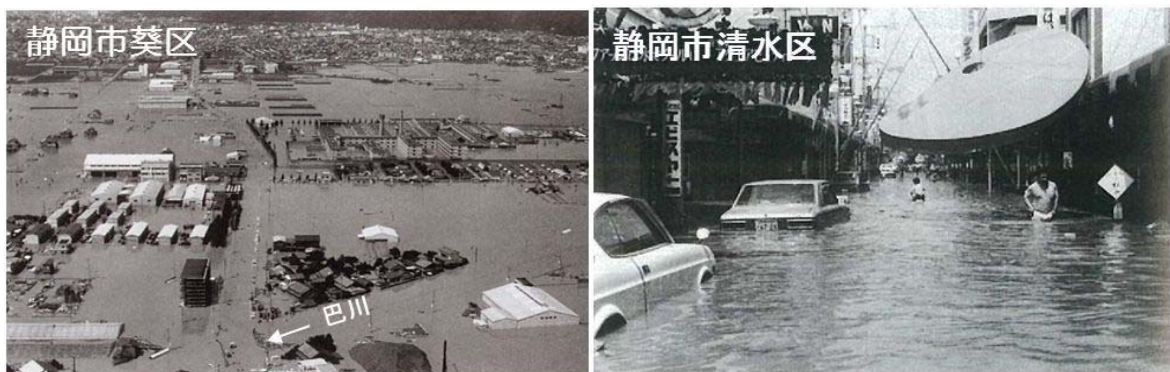
写真 2-1 昭和 49 年七夕豪雨による浸水被害の様子
