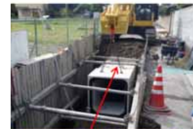
管渠工 沓谷排水区雨水渠
