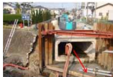
管渠工 高橋雨水ポンプ場放流渠
