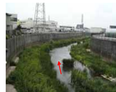
護床工施工済み区間の状況 （古庄橋（6.2k）より下流を望む）
