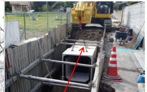
管渠工 沓谷排水区雨水渠
