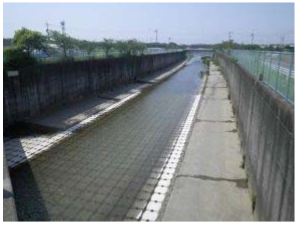
大谷川放水路底張工: L=3km
