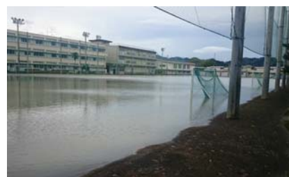
雨水貯留浸透施設の状況 (市立竜南小学校 平成26年10月撮影)
