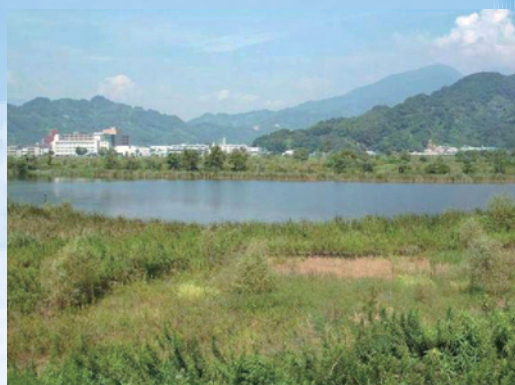
麻機遊水地第3工区の整備
