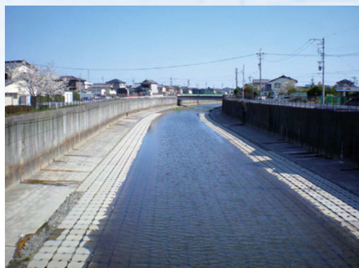
大谷川放水路の整備
