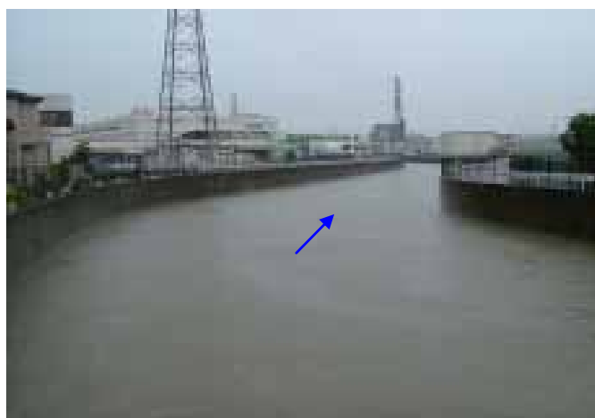
大谷川放水路 -葵区古庄-
