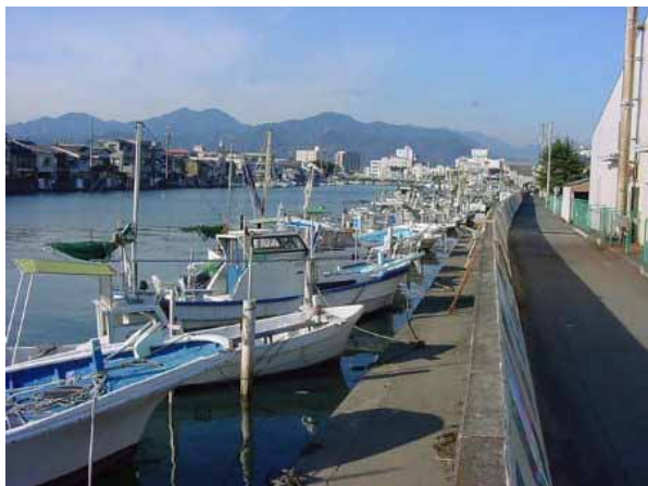
図 2-15 巴川暫定係留施設状況
