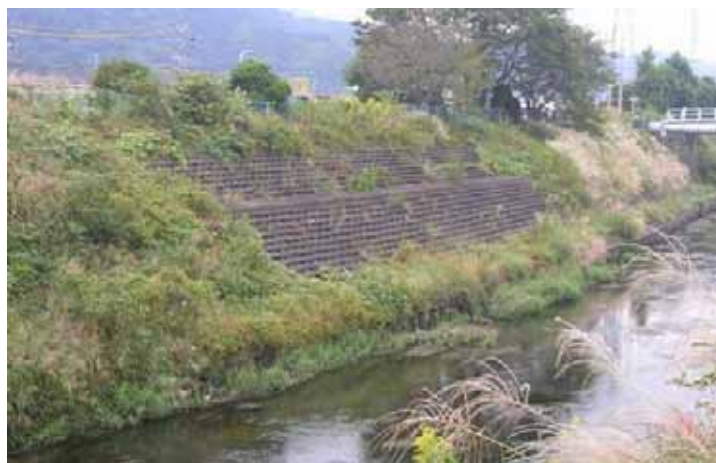
図 2-24 階段護岸の状況 -巴橋上流-
