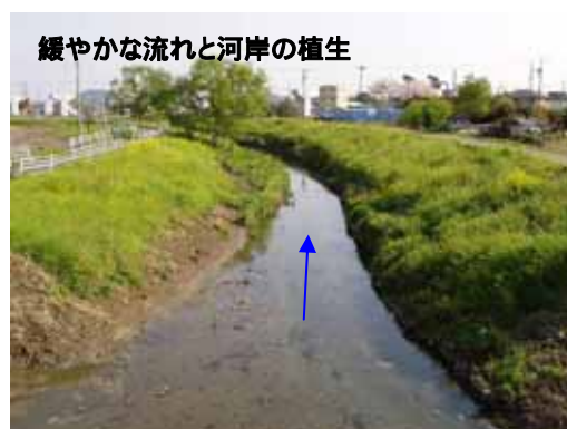
図 2-35 中流部の河道の状況 - 葵区漆山 -
