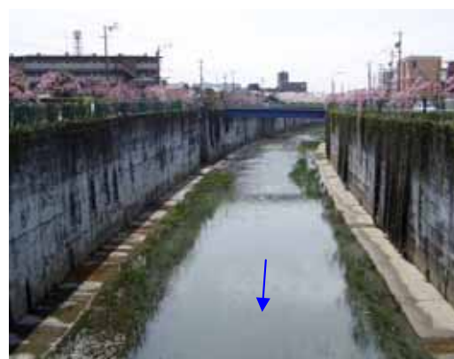
図 2-41 大谷川放水路の状況 - 駿河区小鹿 -
