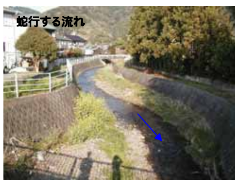
図 2-33 上流部の河道の状況 - 葵区北 -
