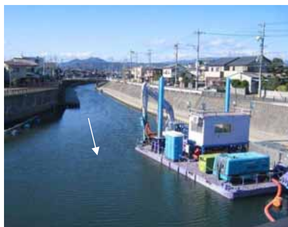
図 2-27 河川浄化の状況（底泥の浚渫）
