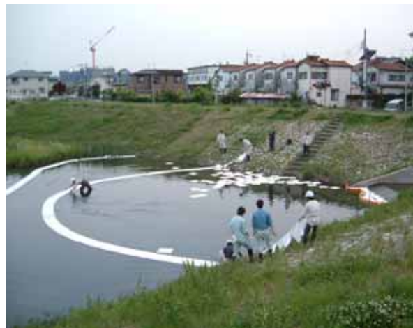
図 4-16 麻機遊水地での油流出事故の状況 -平成16年5月1日-
