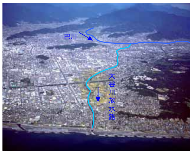
図 1-8 大谷川放水路全景
