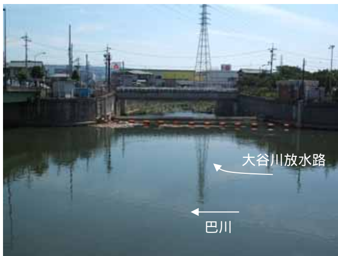
大谷川放水路分流工 葵区古庄-
