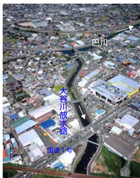
大谷川放水路分流堰 -葵区古庄-
