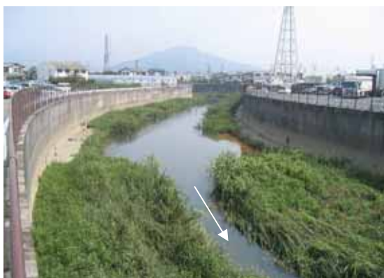
大谷川放水路 -葵区古庄 2 丁目-
