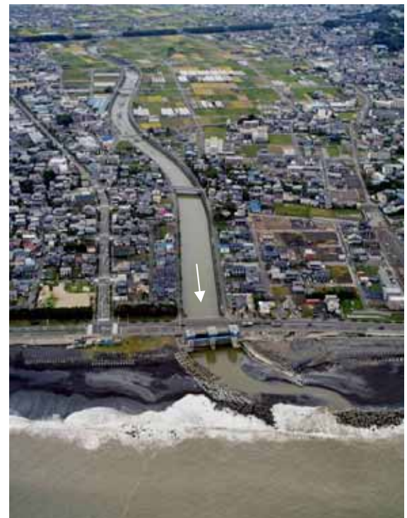
大谷川放水路河口部 -駿河区大谷-
