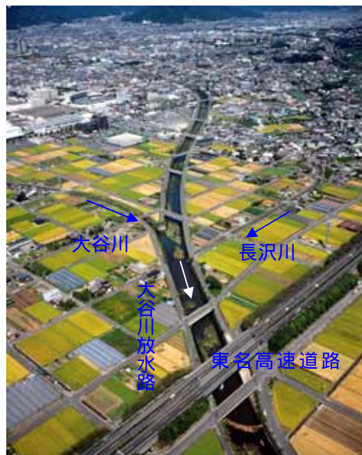
図 1-60 長沢川等の河道状況
