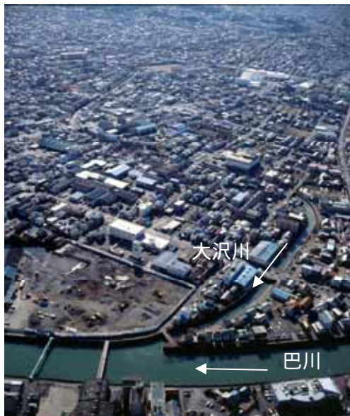
図 1-57 大沢川下流部 -清水区東大曲町付近-
