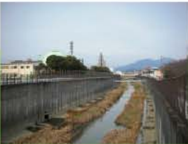
f. 住宅地 ガスタンクは緑に覆われている。
