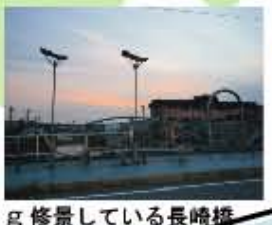
g 修景している長崎橋
