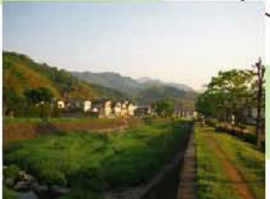
f 水梨橋上流は山が迫り、川の左岸川近くには低層住宅地があり、散策道や緑地・植栽など緑が多い。
