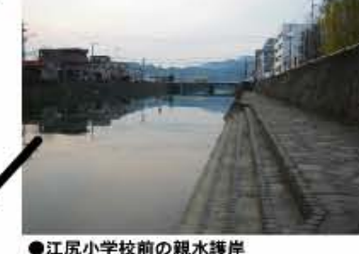
●江尻小学校前の親水護岸
