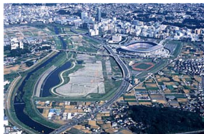
鶴見川(多目的遊水地) (出典：国土交通省京浜河川事務所HP)
