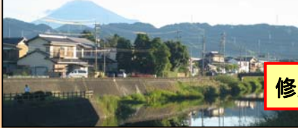
次世代に引き継ぐべき景観（能島橋）
