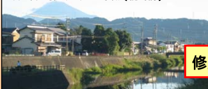
次世代に引き継ぐべき景観（能島橋）
