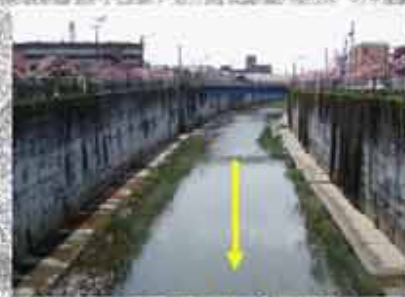
自立のコンクリート護岸によって周辺から隔離されている。
