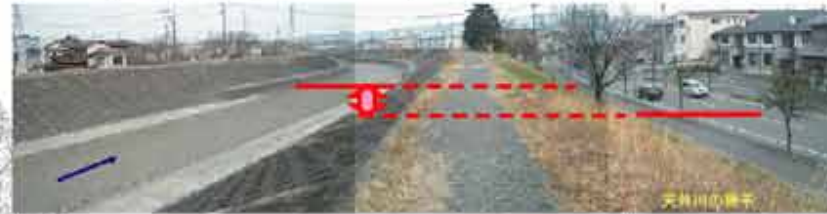
長尾川の扇状地区間は、断切れが発生し「天井川」になっている
