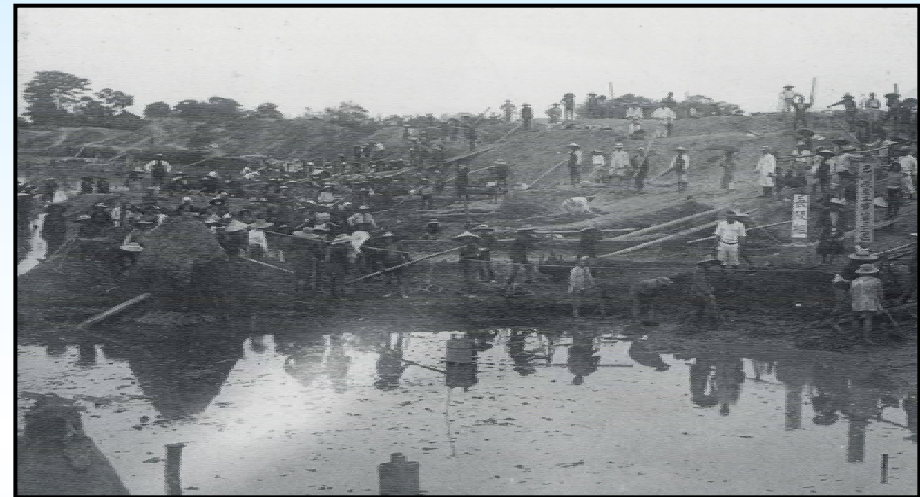
巴川の改修状況（明治43年）
