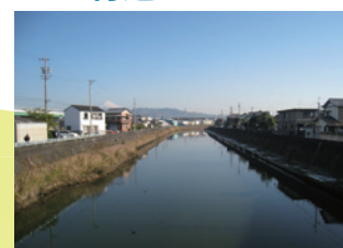
のうしあし 能島橋から下流を見た様子
