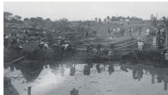
明治43年に行われた巴川の工事の様子(出展: 上土誌)
