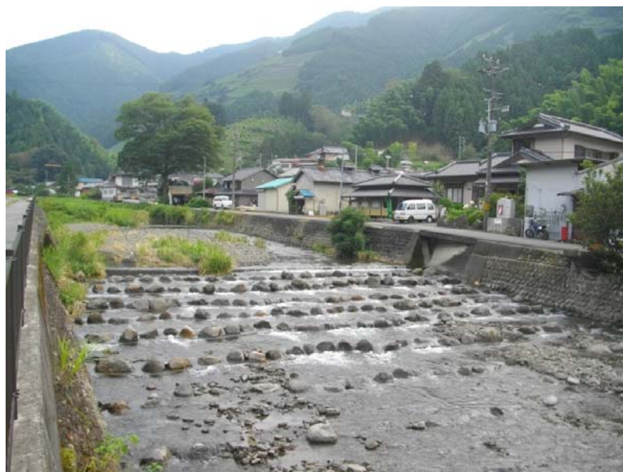
写真 4.1 床固めの一例 (0.8k 下田橋上流付近)
