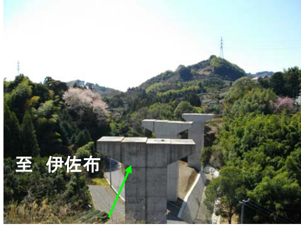
③4号橋梁部
