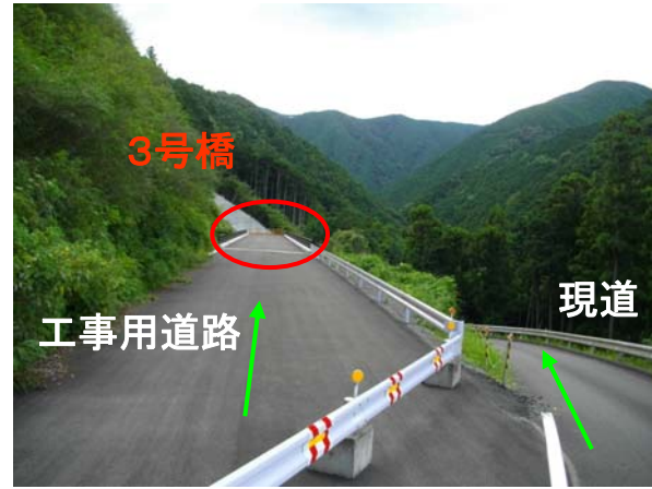
⑥工事完了終点部
