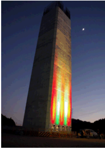
【橋脚ライトアップ①】
