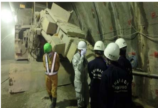
トンネル工事現場見学
