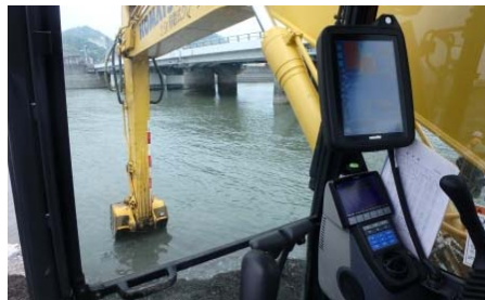
ICT建機掘削状況
