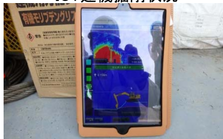
タブレット端末による施工管理状況
