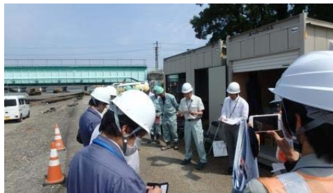
工事概要説明
