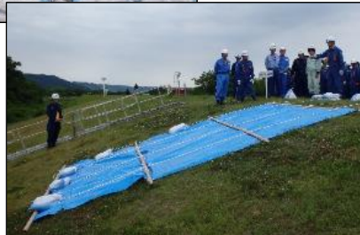
【シート張り工法】
