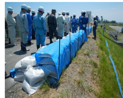
改良積み土のう工法
