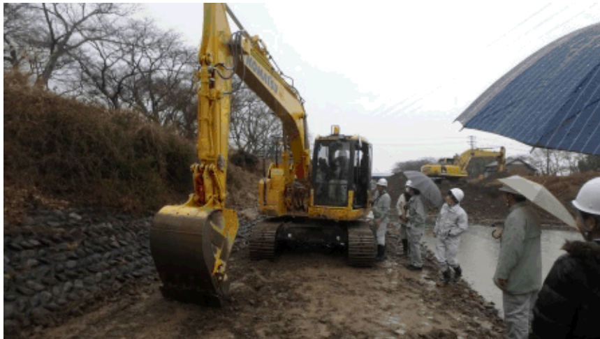
MC(マシンコントロール)による建機
